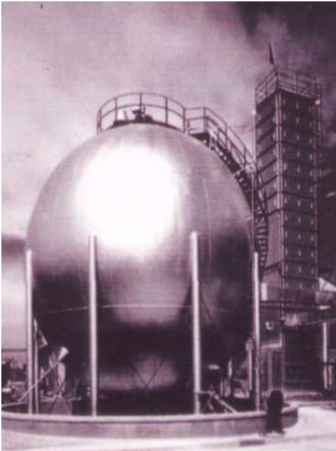
Esfera de Oxígeno Capacidad en Oxígeno 600.000 lt. Temperatura de Servicio : -212 °C Planta de L Air Liquide – Plaza Huincol Neuquen – 1.996
